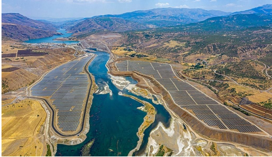
Şekil 4.1. Aşağı Kaleköy Yardımcı Kaynak Güneş Enerji Santrali
