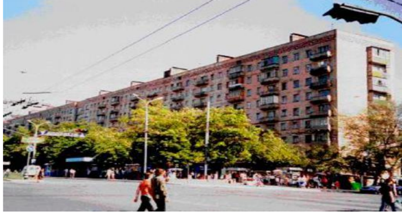
Şekil 2.2. Mariupol, Ukrayna’da bulunan ve AAM kullanılarak inşa edilen 9 katlı bina [36]
