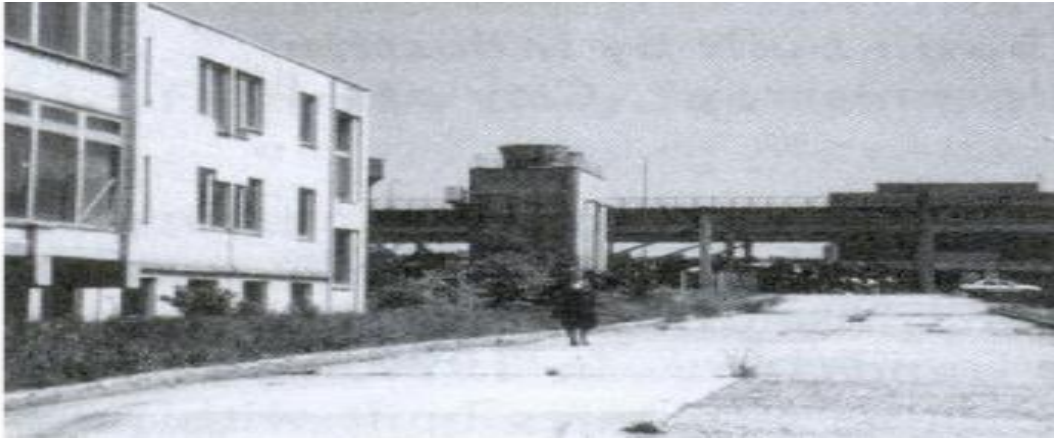
Şekil 2.3. AAM kullanılarak üretilen beton ile inşa edilen yol [12]
