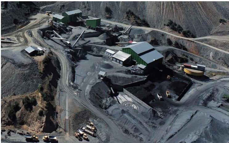
Şekil 3.3. Avnik demir işletmesine ait görüntü (Anonim, 2023a)
