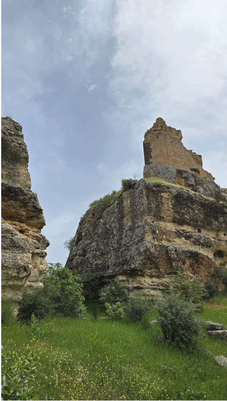
Fotoğraf 52: Selman Kalesi Batı Cephesinde Ki Hendek
