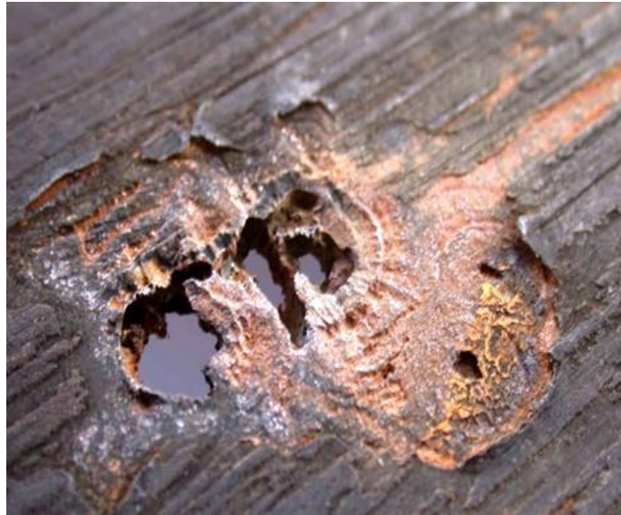
Şekil 1.7. Biyolojik korozyona uğramış su deposu (URL-7 2018)
