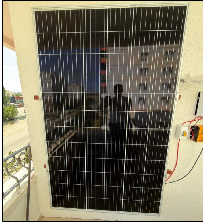
Şekil 3.12. Montajı yapılan 395 W monokristal güneş paneli
