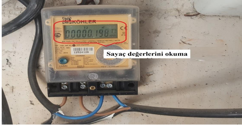
Şekil 2.4. Elektrik sayaç değerleri okuma
