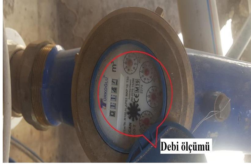
Şekil 2.8. Sıcak su sayacı ile debi ölçümü
