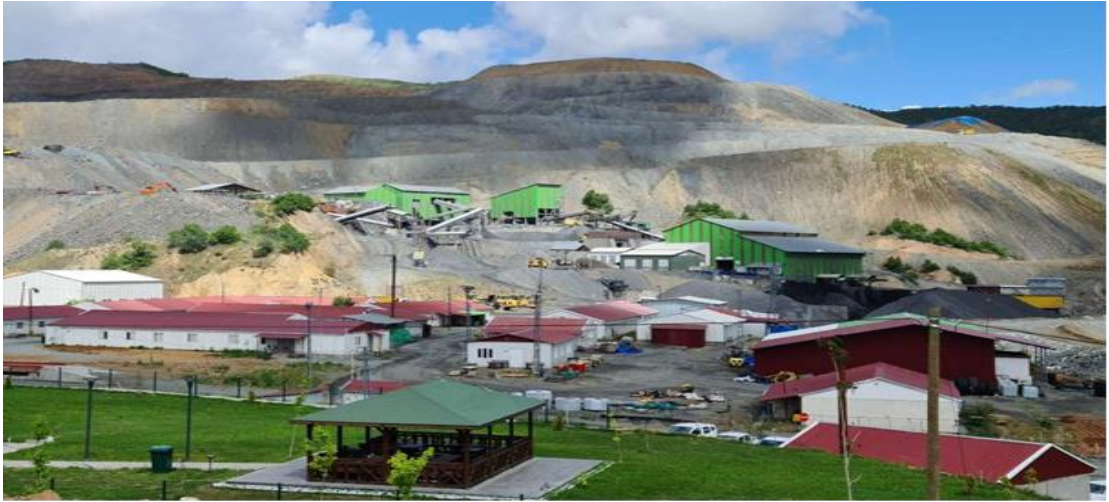
Şekil 3.1. Örneklem yapılan türlerin kirlетici unsuru olan maden sahası
