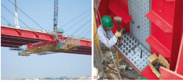
Şekil 5. Çelik Konstrüksiyon Köprü İnşaa Faaliyetlerinde Cıvatalı Bağlantılar [7]
