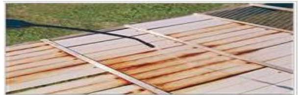
Şekil 6. Hızlandırılmış tuzlu su korozyon testi [11].
