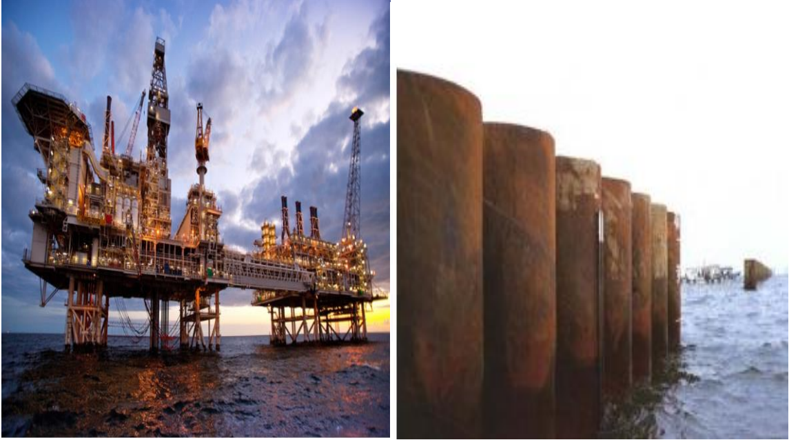
Şekil 1.1. Denizlerde ve sularda bulunan metalik malzemelerde gerçekleşen homojen korozyon (URL-1 2021)
