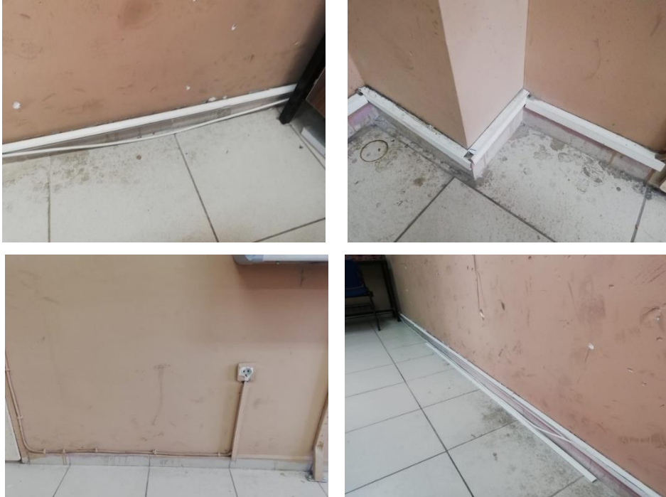
Şekil 3.4. Kablo ve kablo kanalı tesisatı
