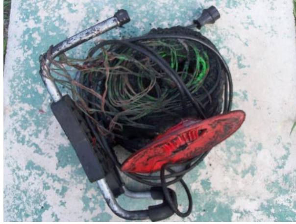
Şekil 1.16. Tamamen açılmadan kullanılan seyyar uzatma kablosunun aşırı ısınarak yanması (URL-23, 2022)
