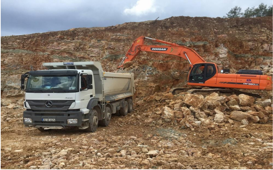
Şekil 4.1. Ekskavatör ocakta kamyonu malzeme yüklerken
