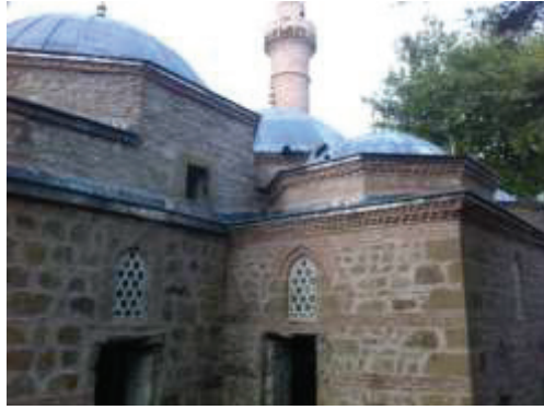
Fotoğraflar 16,17: Almasıık duvarlarda malzeme ve yapım tekniđi uyumsuzluđu
