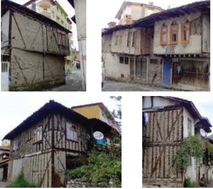
Şekil 9 – İskilip Evleri Yapım Sistemleri
