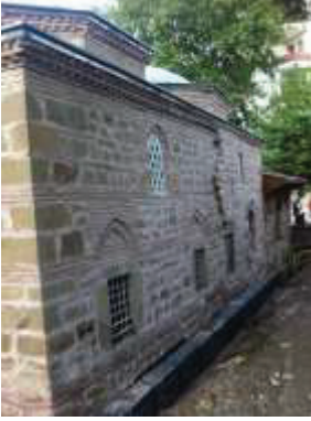
Fotoğraflar 16,17: Almasıık duvarlarda malzeme ve yapım tekniđi uyumsuzluđu
