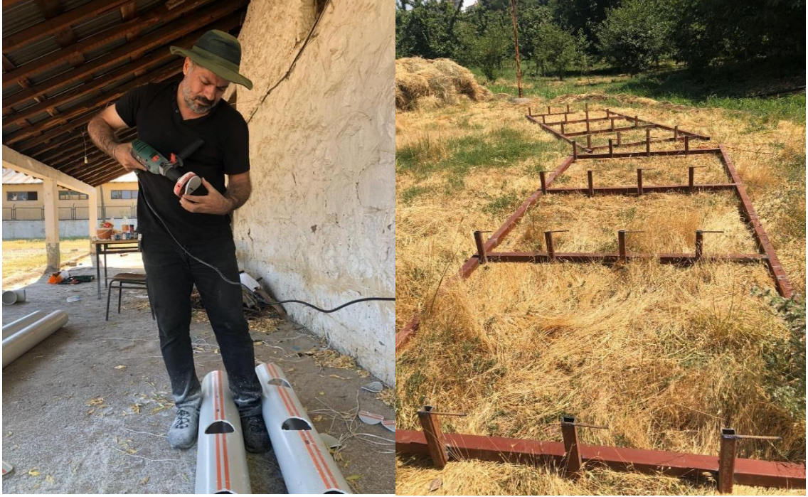
Şekil 2. Pvc borularının ve deneme iskeletinin hazırlanması
