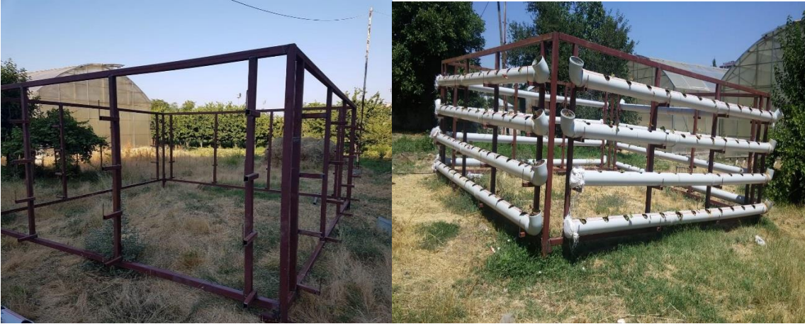
Şekil 3. Deneme iskeleti ve pvc borularının yerleştirilmesi
