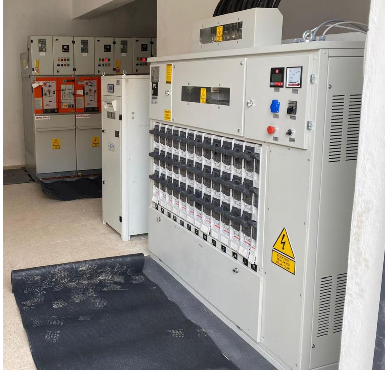
Şekil 2.3. Üzerinde durulan yerin yalıtılmasında kullanılan izole halı
