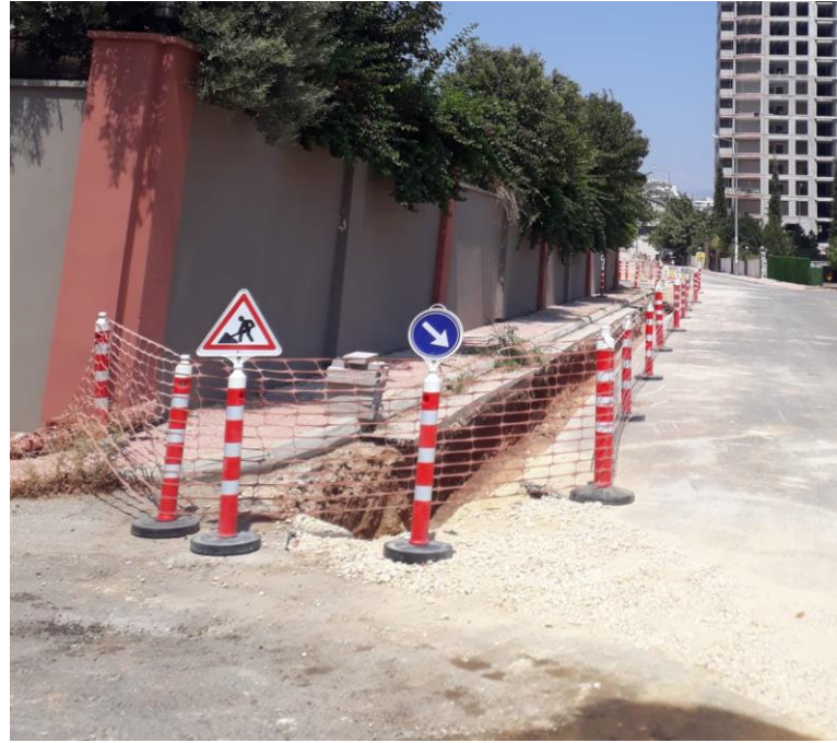
Şekil 3.4. Çalışma sahasında kanal kazı çalışmaları sırasında alınan çevre güvenliği önlemleri
