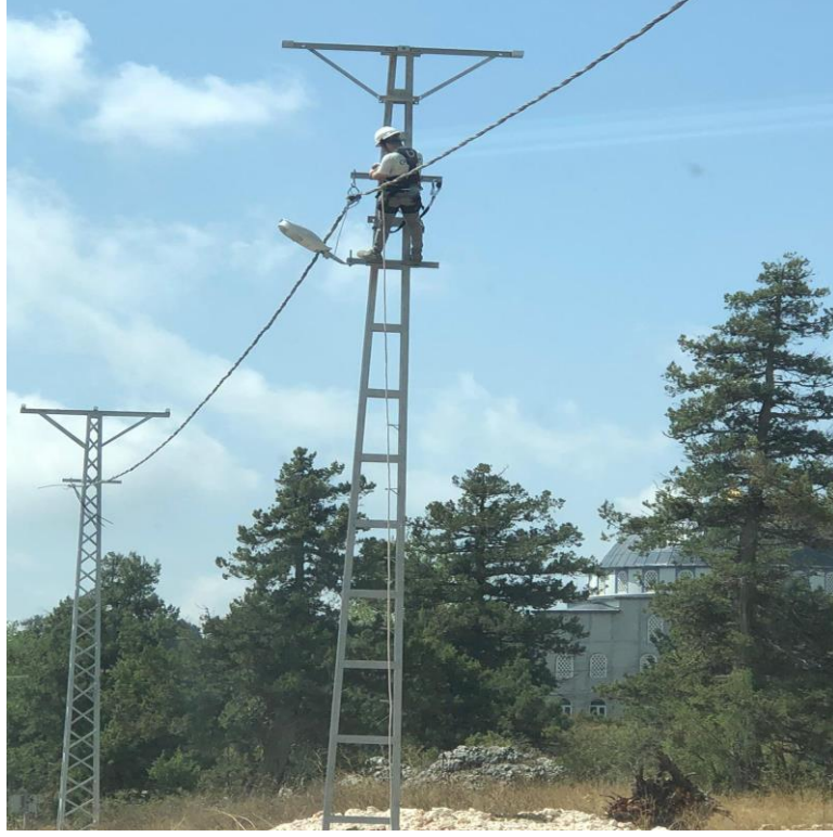
Şekil 3.1. Çalışma sahasında %100 bağlı kalma kuralına uygun iletken çekme işlemi
