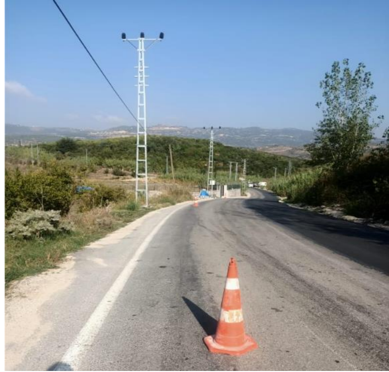
Şekil 3.2. Çalışma sahasında iletken çekme işlemine başlamadan önce alınan çevre güvenliği önlemleri
