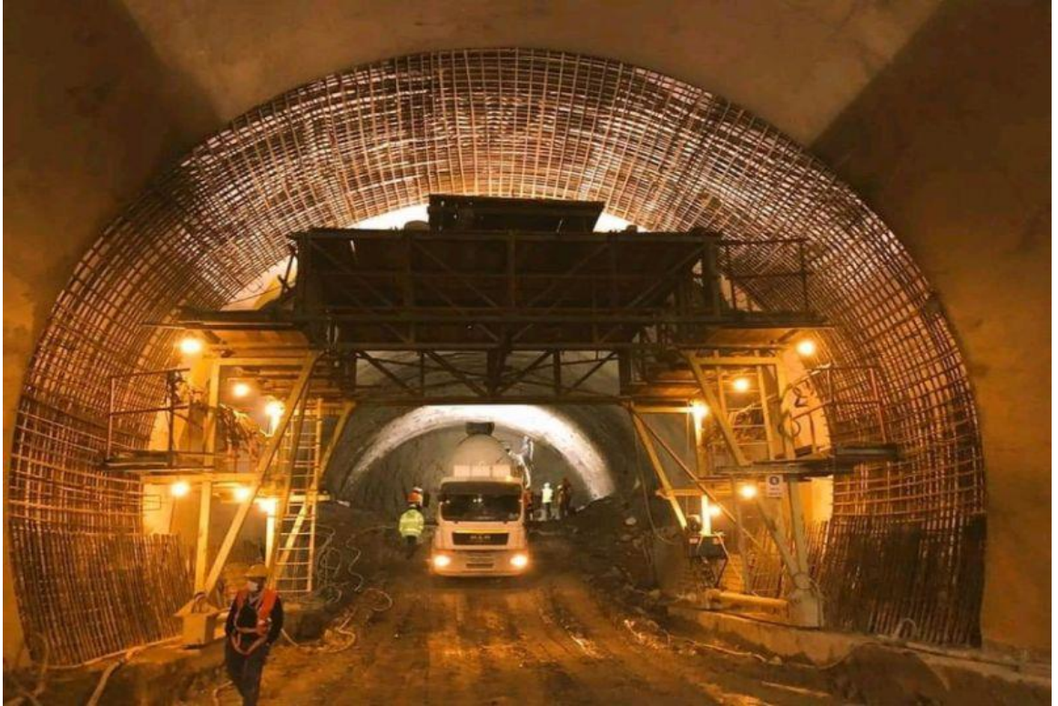
Şekil 3.2. Kırık (İspir ) Tüneli çalışma alanı
