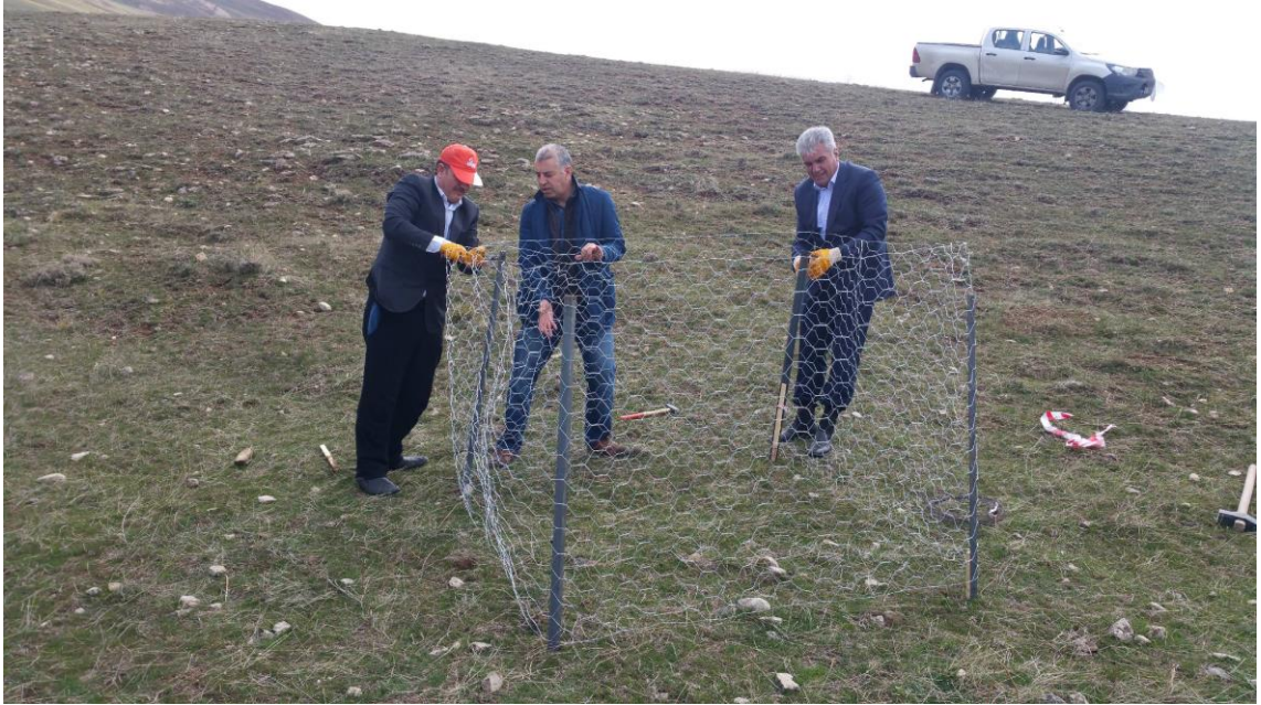
Şekil 3.2. Çalışılan meraya kafes yerleştirme çalışmasından görünüm
