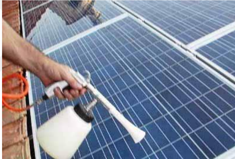
Şekil 5.3. Sprey tabanca ile fotokatalitik kaplama uygulaması
