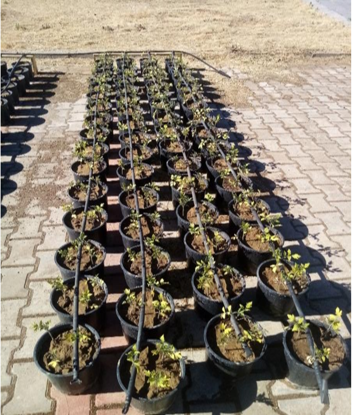
Şekil 3.7. Damla sulama sisteminin kurulması
