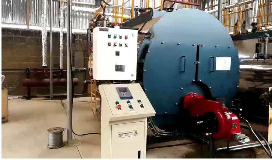
Şekil 4.4. Biyogaz yakıtlı brülör
