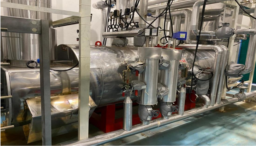
Şekil 6.11. Atık ısı kazanı
