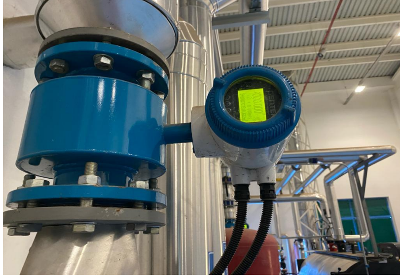
Şekil 6.4. Akış ölçer debimetreler
