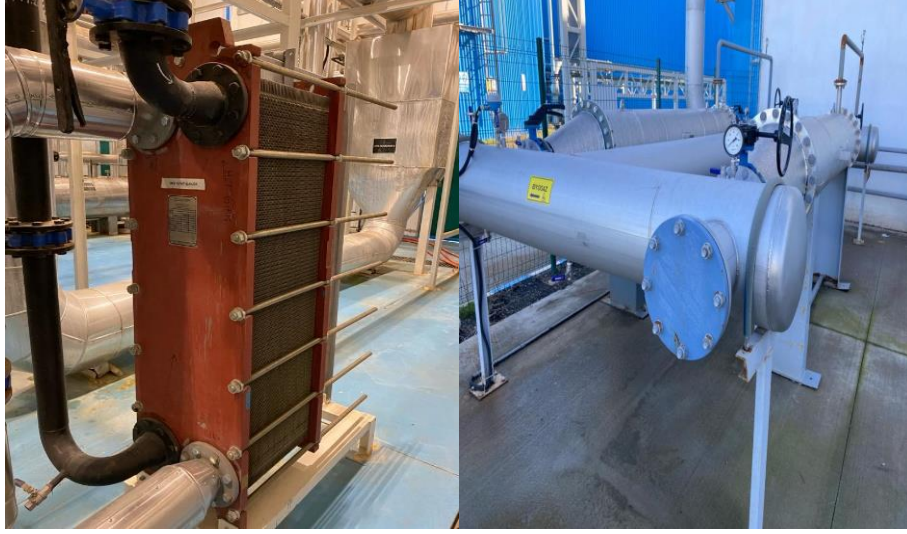
Şekil 6.9. Plakalı ve borulu ısı deęiřtirciler
