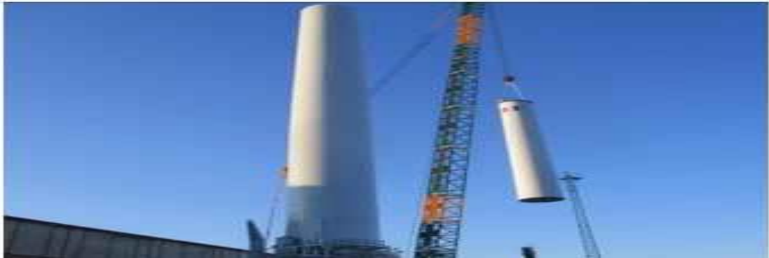
Şekil 1.14. Türbin kulelerinin montajı (Yavuz ve Özbay, 2020)
