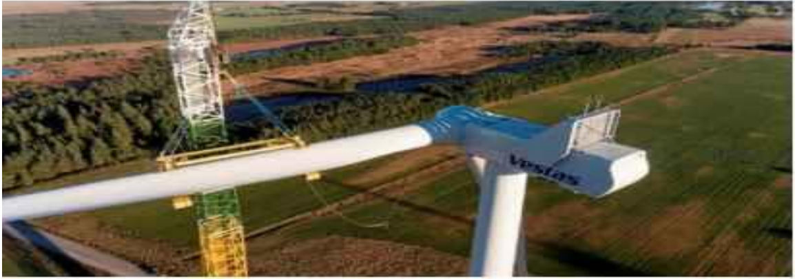
Şekil 1.15. Türbin kanatlarının montajı (Yavuz ve Özbay, 2020)
