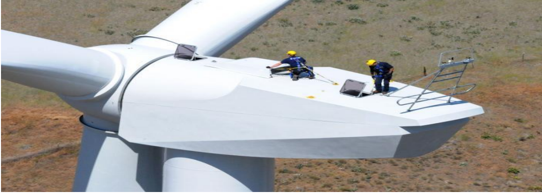
Şekil 1.16. Rüzgar Türbini bakım çalışmaları (Url-14)
