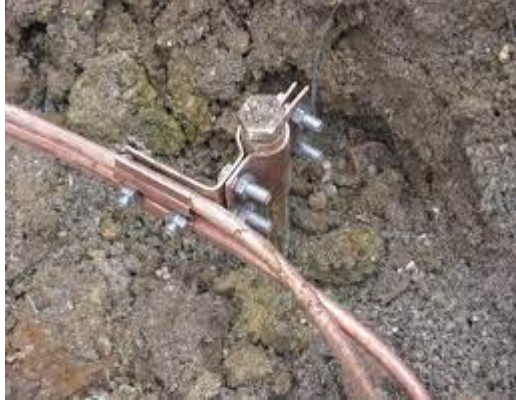
Şekil 2.4. Topraklama tesisatı yapımı(çubuğun toprağa gömülmesi)
